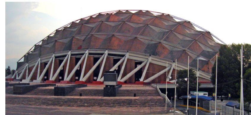
Ilustración 2. Palacio de los Deportes, diseñado por Félix Candela, Antonio Peyrí y Enrique Castañeda para los JJ.OO. de México en 1968. Imagen tomada de Cruz (2014).
